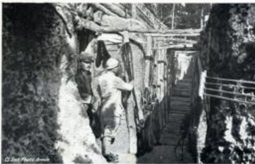
POSTE DE COMMANDEMENT DANS UN BOYAU D'ACCÈS
