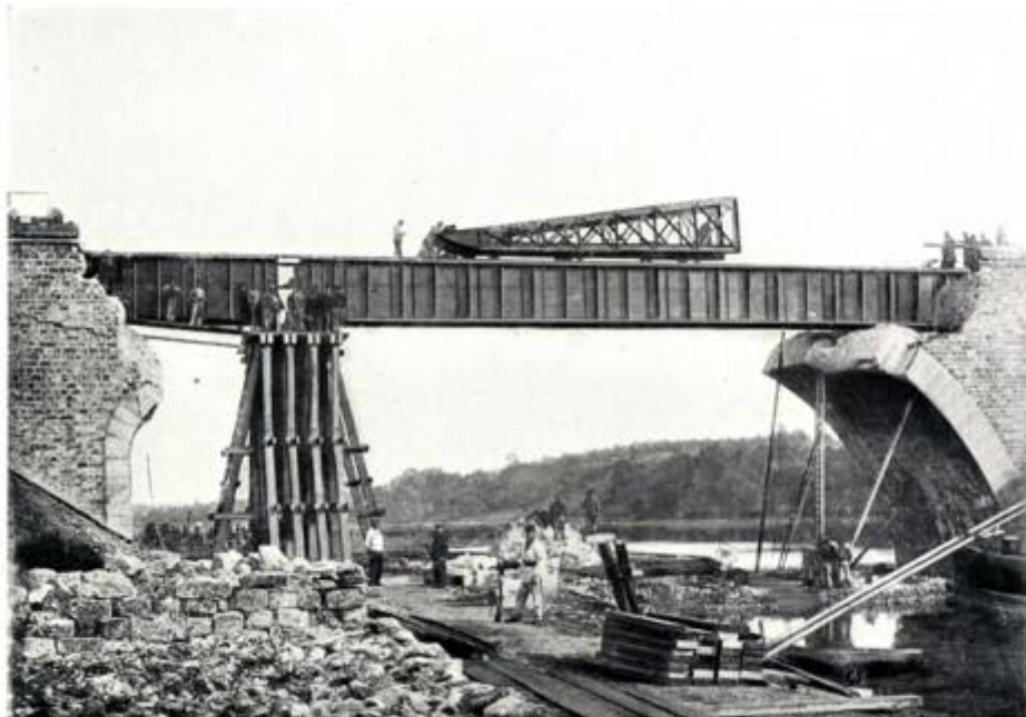
Construction d'un pont provisoire à Trilport (Seine et Marne), septembre 1914 A_HIS6
