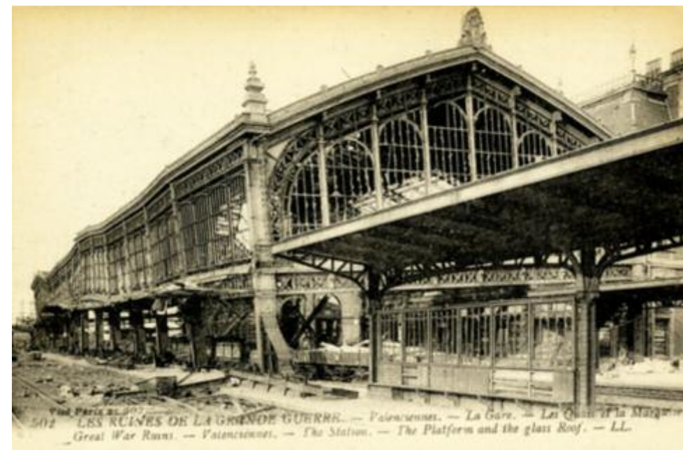
La halle de la gare de Valenciennes - D_CPA9
