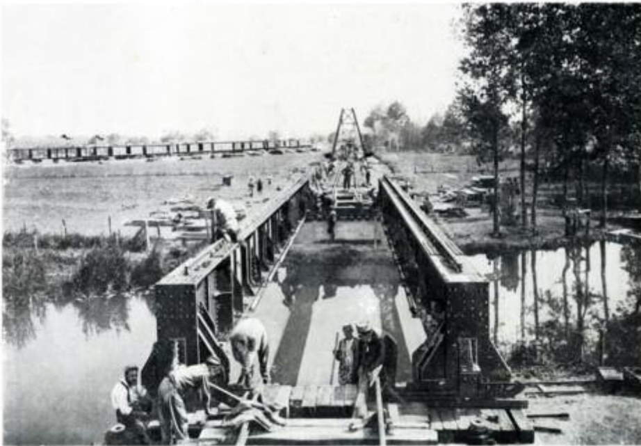
Elargissement du Pont de Froidos (Meuse), juillet 1917 A_HIS4
