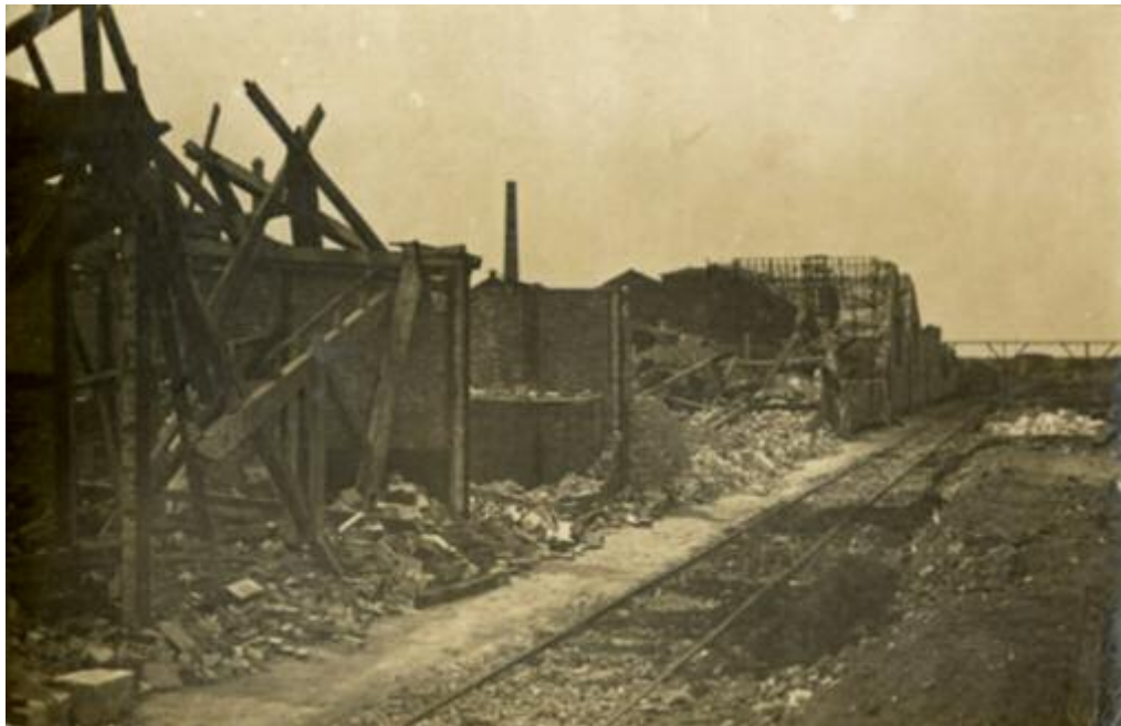
Installations ferroviaires dévastées (lieu non identifié) - D_CPA14
