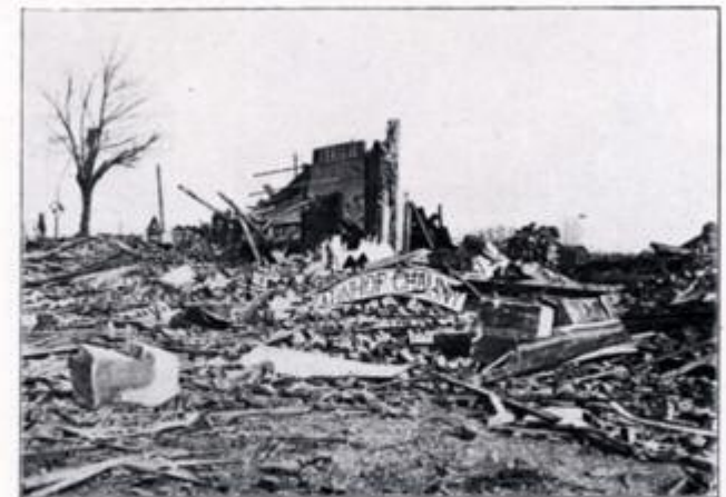
Fig. 55. — Bâtiment des voyageurs de Chauny, tel qu'il a été retrouvé.
