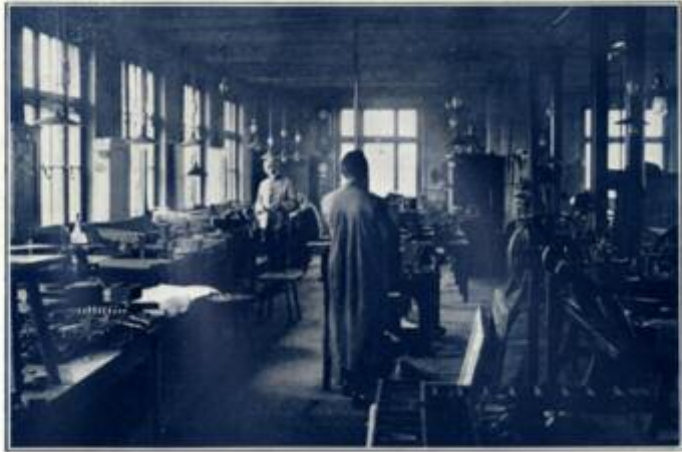
ATELIER DE RÉPARATION DES APPAREILS S. E. S. D'ESSEN HM
